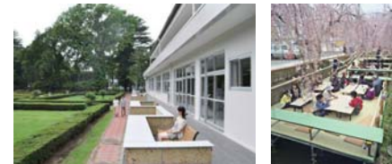
UUプラザ改修
