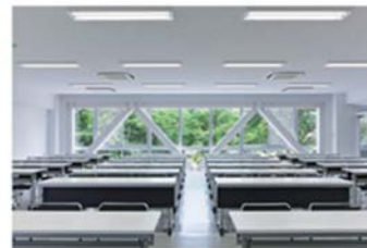
大講義室と耐震ブレース
